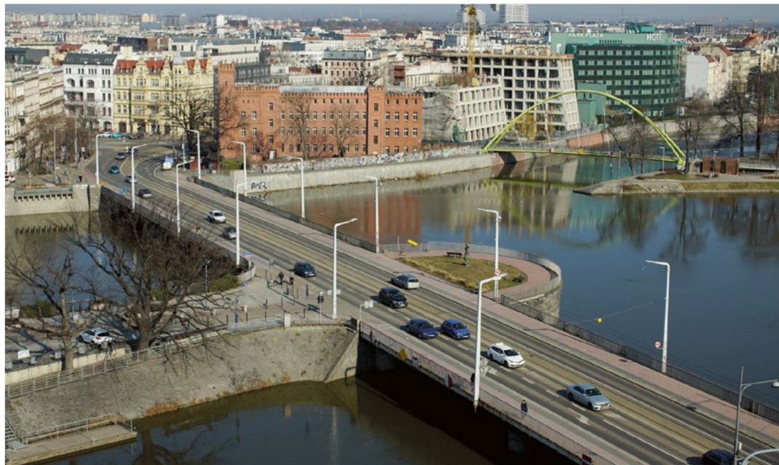
Mosty Uniwersyteckie pójną do remontu. Zostaną naprawione podpory i ułożone nowe chodniki
